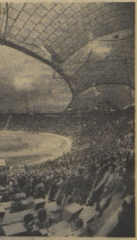
Это главное спортивное сооружение XX Олимпийских игр — большой стадион. Над его зеленым полем и поздно вечером, и в пасмурную погоду всегда будет светить 550 прожекторов, заливающих его ярким светом. Проекторы установлены так, что освещённые ими предметы не отбрасывают теней. Такое освещение поможет спортсменам. Да и телезрители во всех уголках земного шара будут довольны: изображения на экранах телевизоров будет четкими. Даже если пойдёт дождь, не страшно: над стадионом нависла огромная, укреплённая на стальных трюсах прозрачная синтетическая крыша. 4 000 журналистов рассажут о том, кому достанется 1 109 медалей в 21 виде спорта. Это будут самые сильные и ловкие люди 70-х годов XX века.
